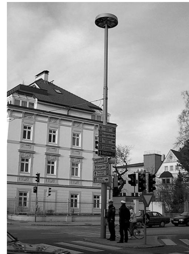
A ještě příklad z Horních Rakous (město Wels). Takováto lampa osvětluje skvěle křižovatku, ale nesvítí do okolních domů ani přijíždějícím řidičům do očí.
