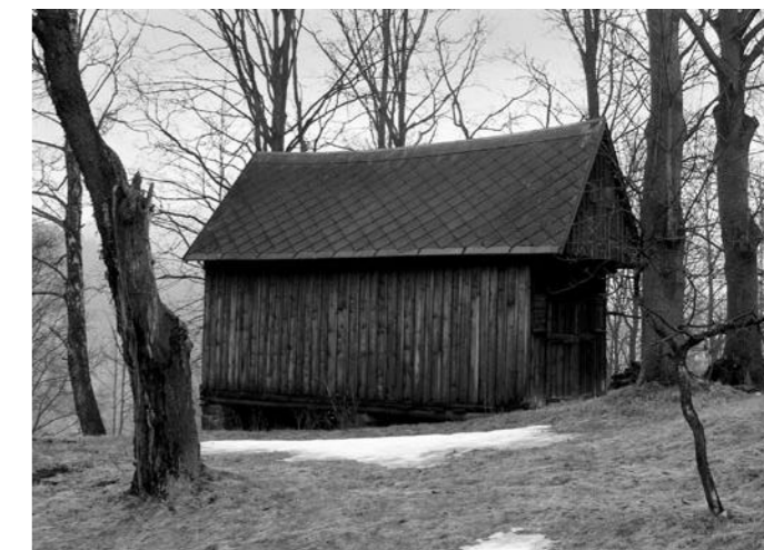
Samostatně stojící bedněný seník, typický pro tzv. krkonošský horský dům (Josefův Důl)
